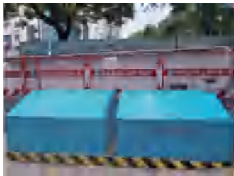
垃圾分类收集池
