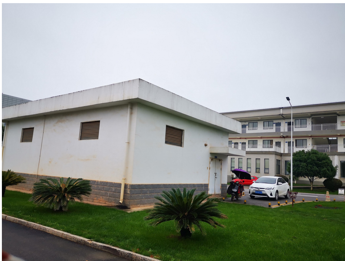
图 4.1-10 危险废物暂存间
