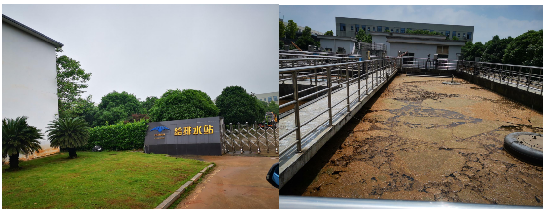
图 4.1-5 依托的污水处理站及回用系统
