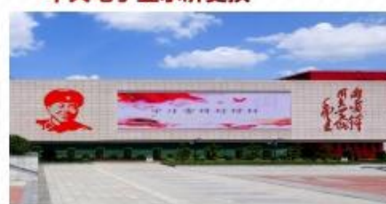
中央电子显示屏更换
