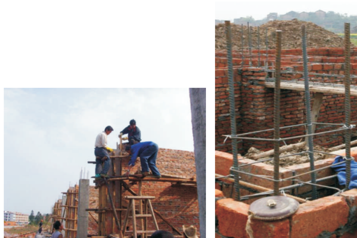
图2.5 先砌墙，后浇筑构造柱
