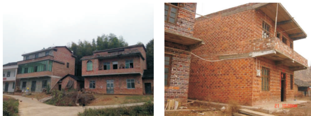
图1.2 我市60%以上的农村民居未设置圈梁和构造柱
