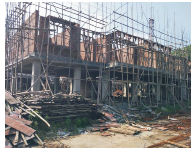
图1.3 此类民居一层为框架结构，二层以上为砖混结构，抗震效果好
