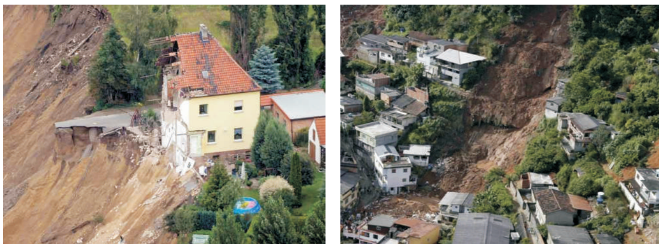
(a)滑坡对建筑物的影响
