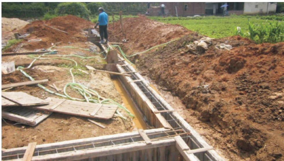
图2.4 建房时按要求设置圈梁很关键
