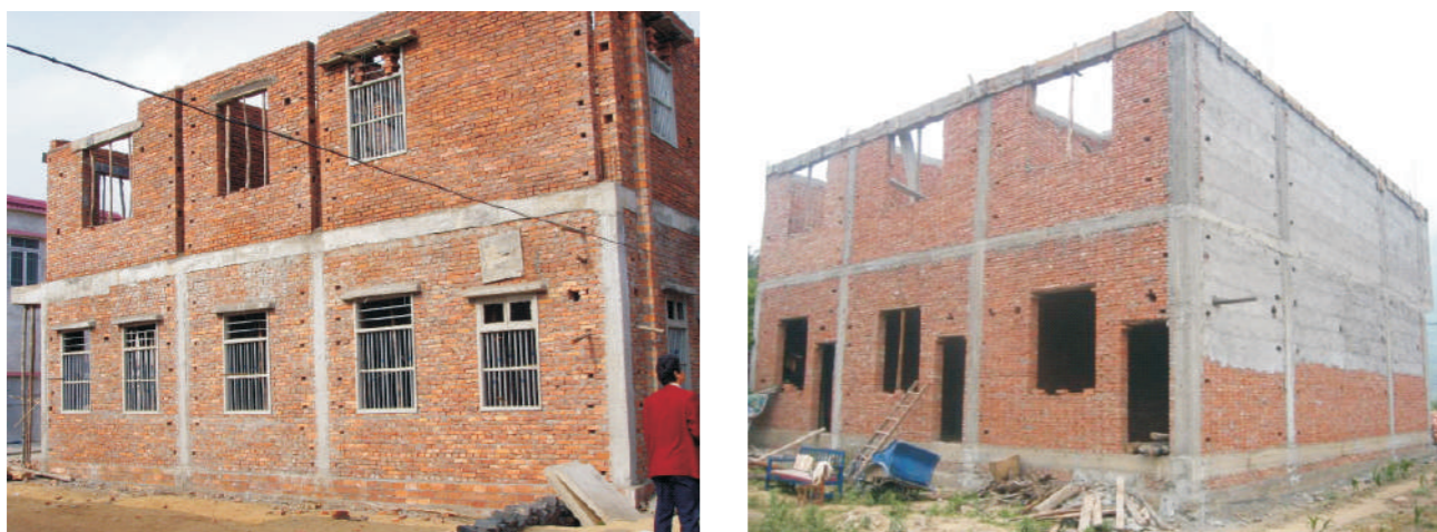
图2.3 结构规则的房屋抗震性能好
