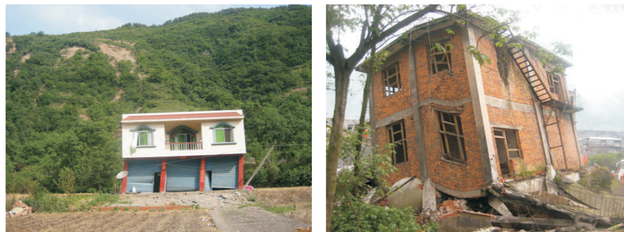
图1.5 地基处理不当而造成的房屋毁坏
