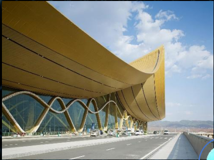
昆明新机场航站楼
