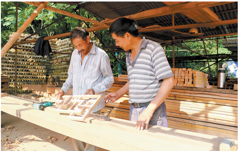
刘锬故居项目现场,工人们正在制作花牙子。
