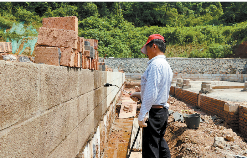
宗祠文化馆项目现场,工人对墙砖进行仿古处理。
