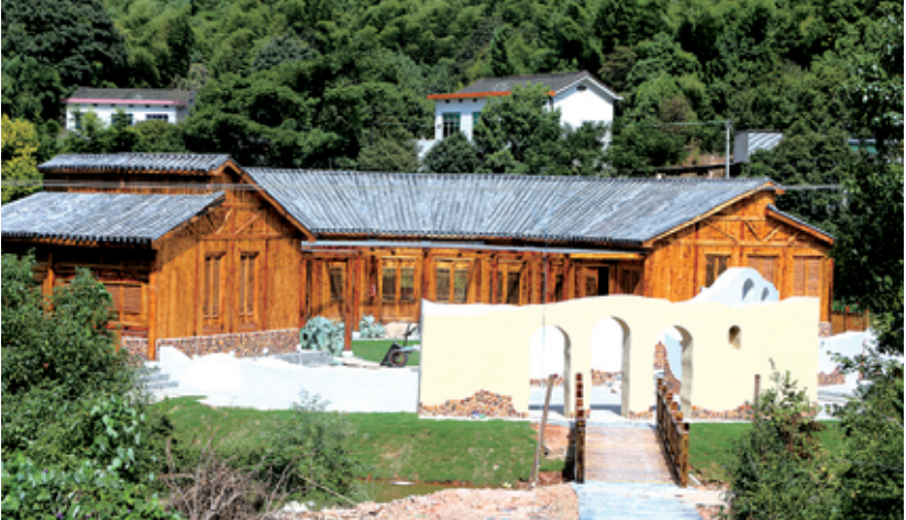
昭山镇七星村美丽乡村记忆馆正进行内部装修。该馆将通过照片、视频、资料、物品等方式真实再现村民生活,挖掘村史历史、文化及特色。
