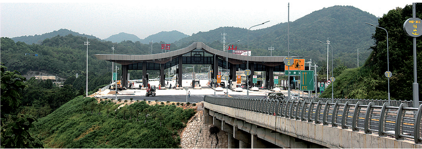
京港澳高速昭山北互通建设完工,已具备通车条件
