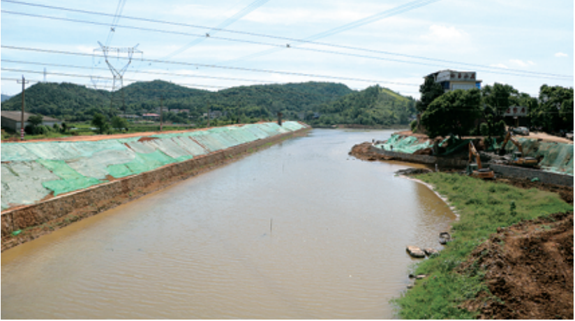
王家晒渠水系改造正在进行河道清淤,堤岸加高培厚。
