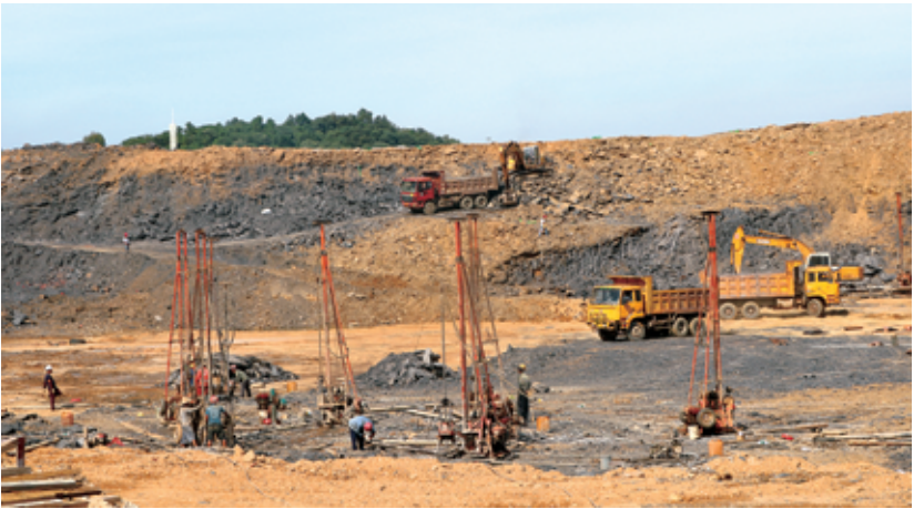
棚户区改造集中安置区二期开工建设。
