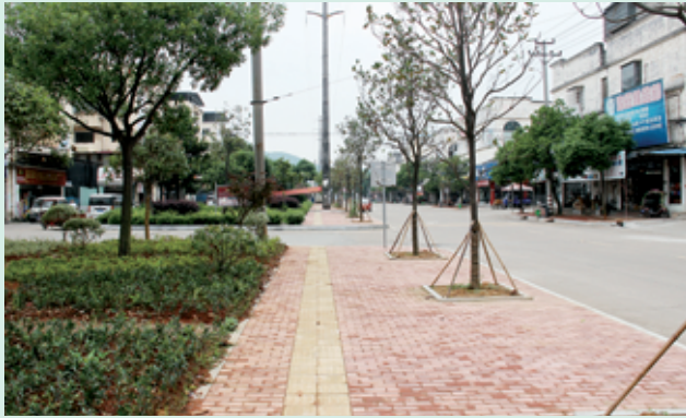
长株潭大市场新修建的人行道及盲道。
