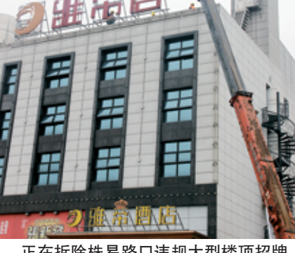
正在拆除株易路口违规大型楼顶招牌。
