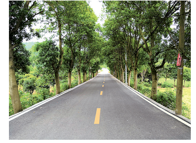
新建的金星路穿梭在青山绿水间,是一条生态路,更是一条富民路。
