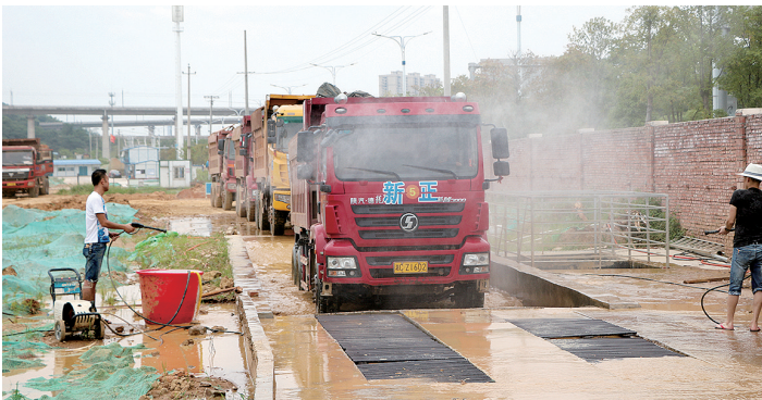
渣土运输车辆冲洗干净后才能上路。图为昭山示范区湖南惠恩生殖与遗传专科医院项目现场。
