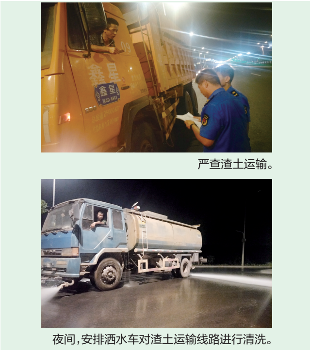
夜间，安排洒水车对渣土运输线路进行清洗。
