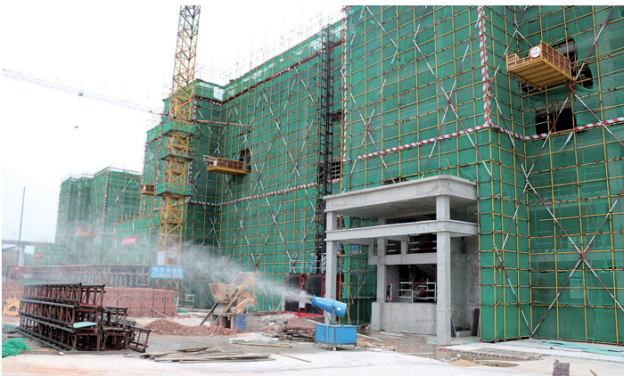
“喷雾炮”走进项目除霾降尘。图为棚户区改造集中安置小区二期项目现场。
