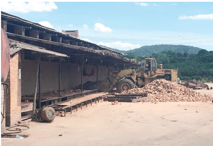
工业企业退出生态“绿心”。图为湘潭市岳塘区新型墙材厂拆除现场。
